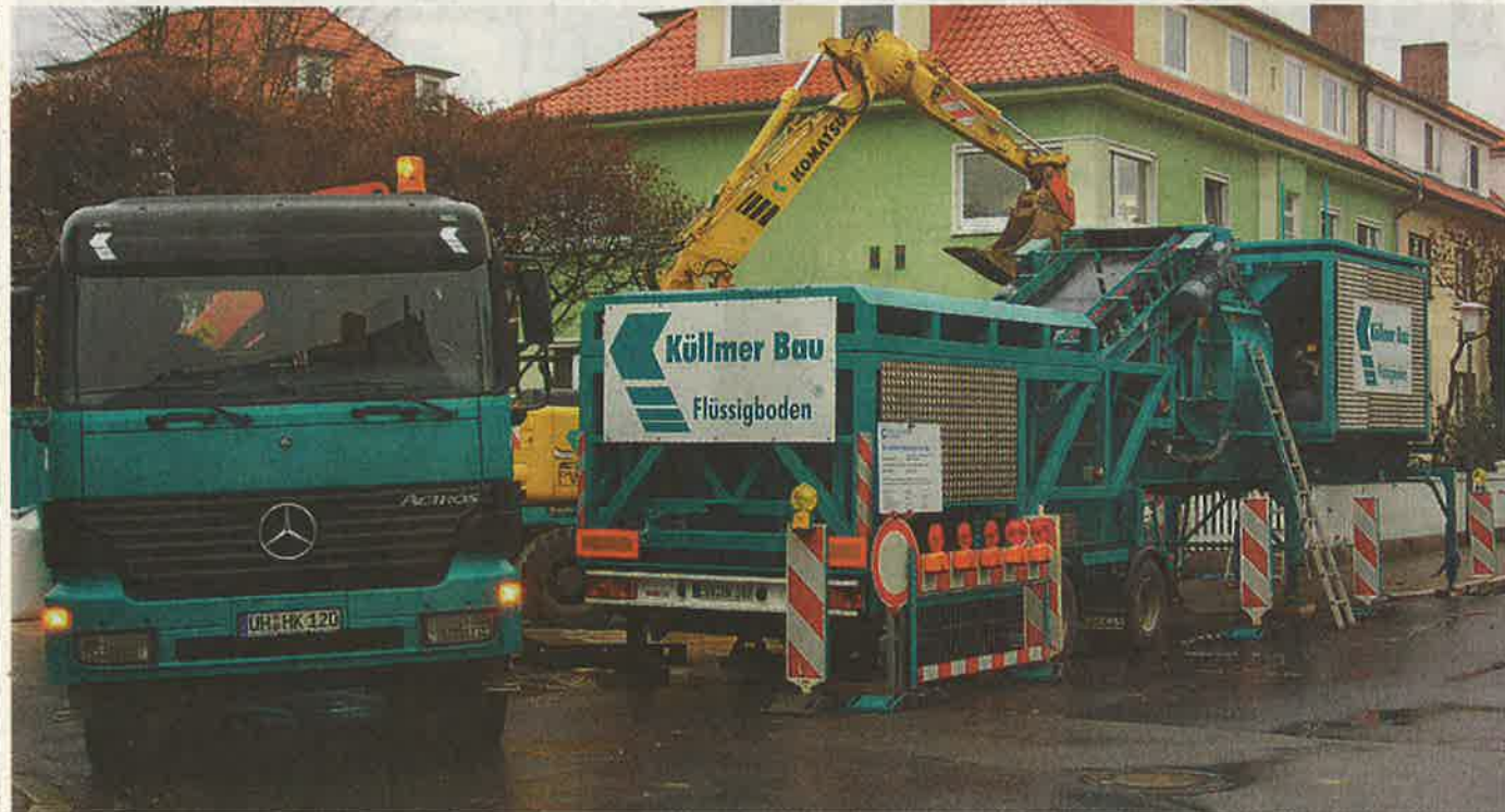
Direkt am Graben wandelt die Küllmer-Anlage Erdaushub in Brei, der den Boden über den neuen Rohren wieder schließt. Foto Küllmer
